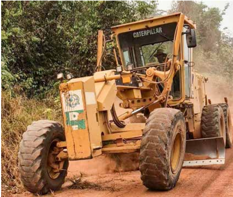
RO-484, também conhecida como P-18 e Linha 192, conecta as Rodovias 370 e 491, no município de Santa Luzia d'Oeste
