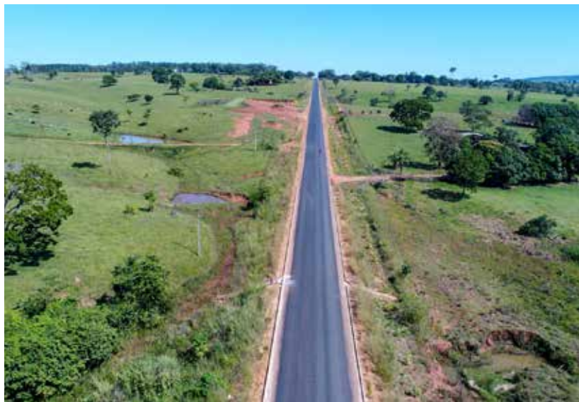
Segundo o governador Marcos Rocha, serão pavimentados 84 km na RO-370, TransRondônia, indo de Corumbiara até o trevo da pedra
